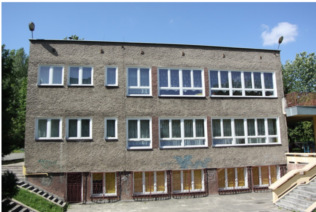
Fot. 11. Będzin, Przedszkole Miejskie Nr 10 – elewacja wschodnia
