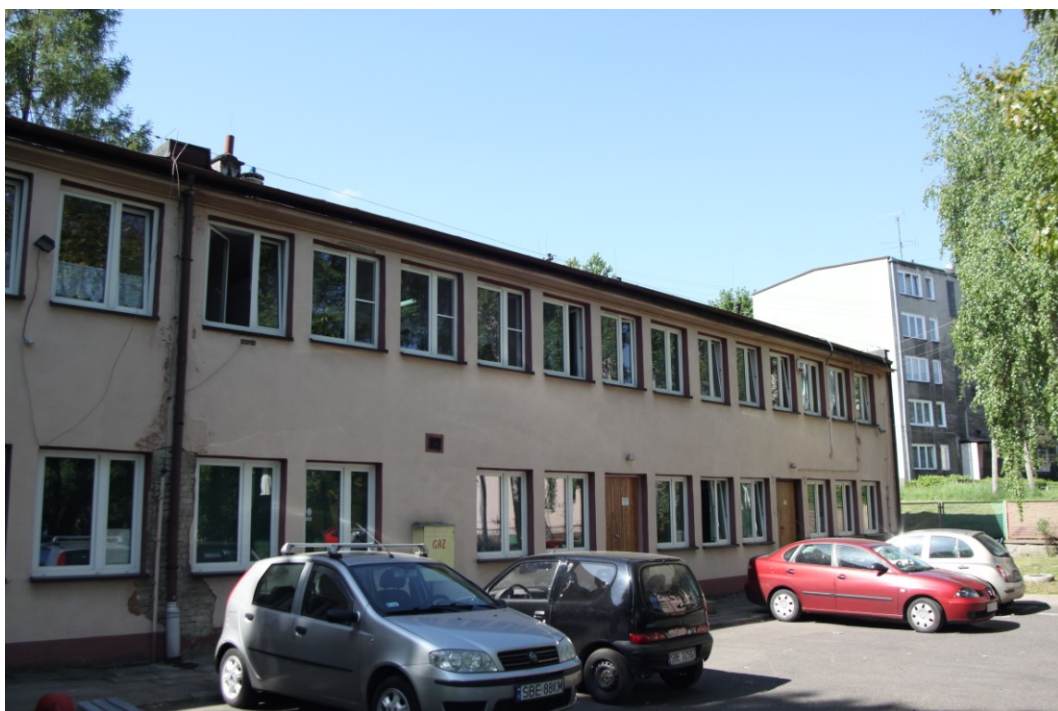
Fot. 8. Będzin, Przedszkole Miejskie Nr 5 – elewacja północna
