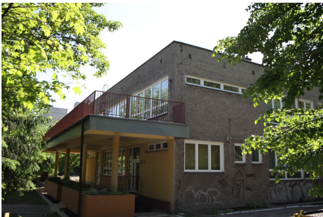
Fot. 12. Będzin, Przedszkole Miejskie Nr 10 – elewacja północna i zachodnia
