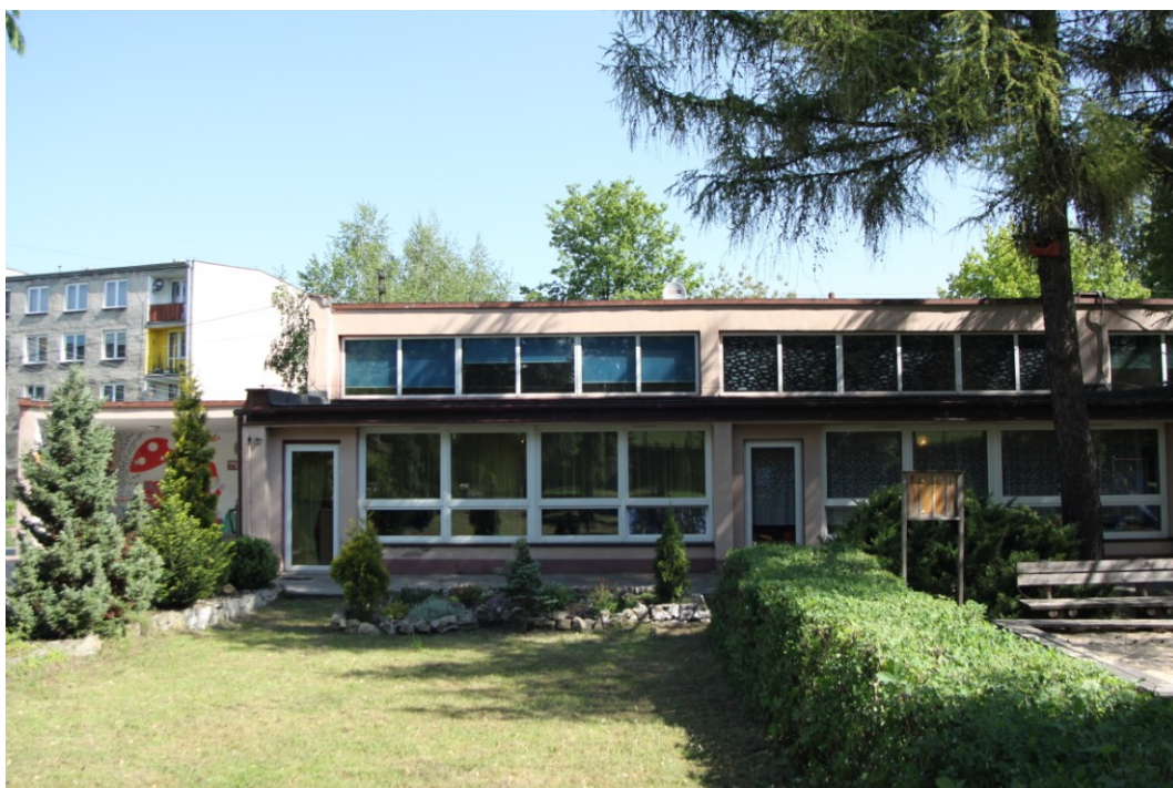
Fot. 4. Będzin, Przedszkole Miejskie Nr 5 – elewacja południowa
