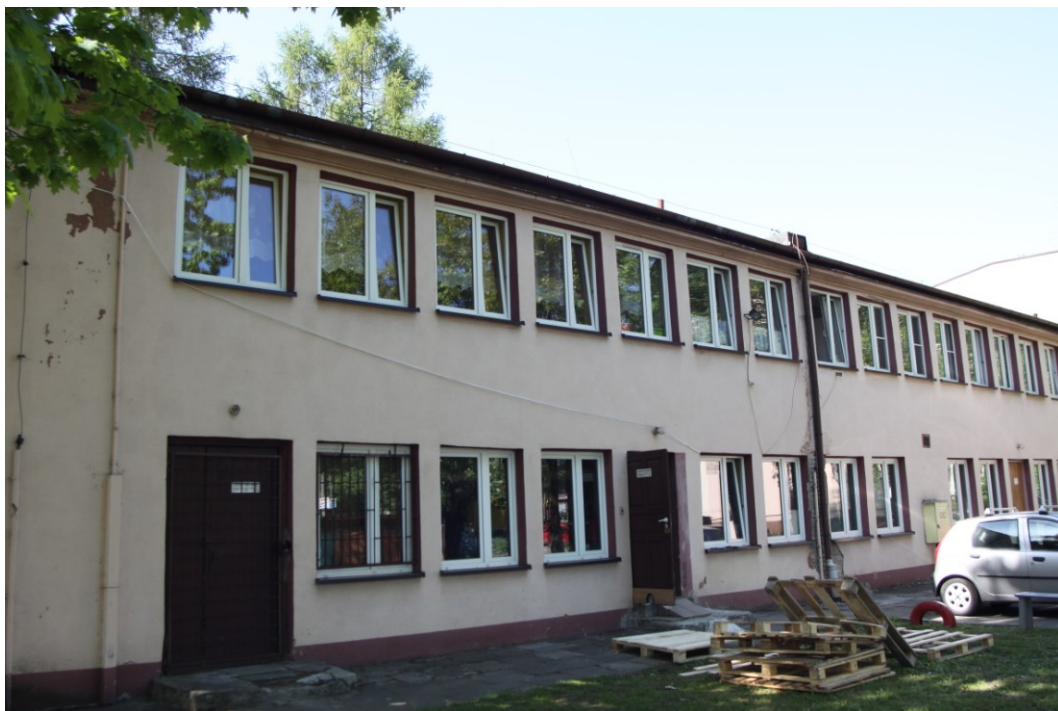
Fot. 7. Będzin, Przedszkole Miejskie Nr 5 – elewacja północna
