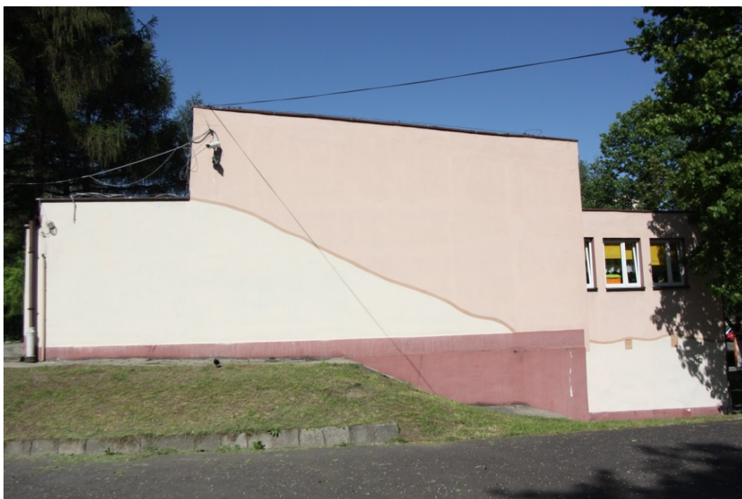
Fot. 6. Będzin, Przedszkole Miejskie Nr 5 – elewacja wschodnia
