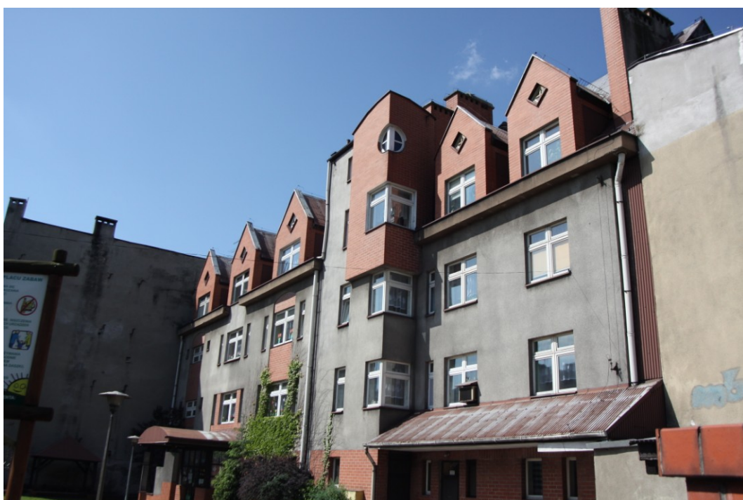
Fot. 2. Będzin, Przedszkole Miejskie Nr 1 – elewacja wschodnia
