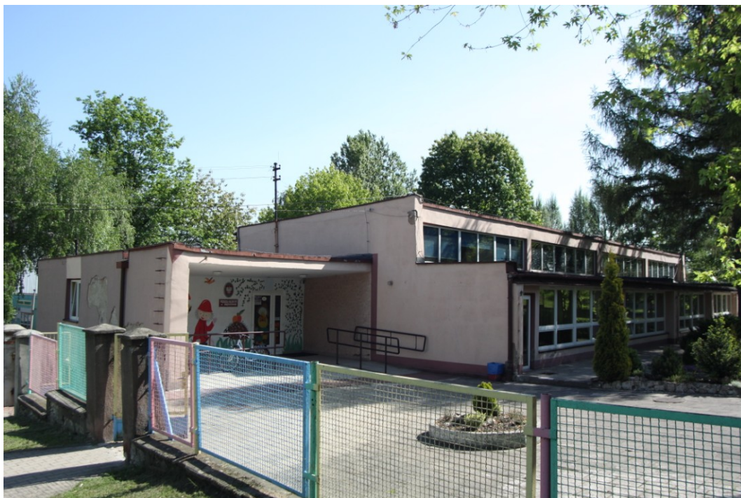
Fot. 3. Będzin, Przedszkole Miejskie Nr 5 – elewacja zachodnia
