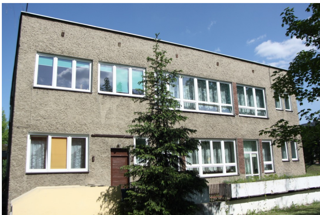
Fot. 10. Będzin, Przedszkole Miejskie Nr 10 – elewacja południowa
