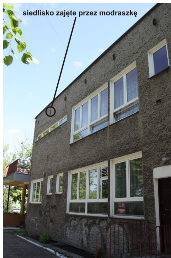
Fot. 9. Będzin, Przedszkole Miejskie Nr 10 – elewacja zachodnia
