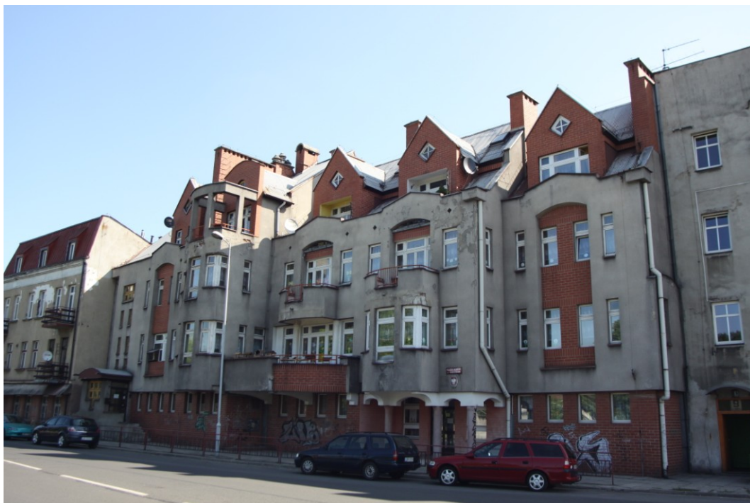
Fot. 1. Będzin, Przedszkole Miejskie Nr 1 – elewacja zachodnia
